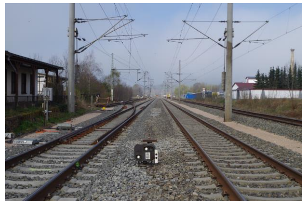
Erneuerung der durchgehenden Hauptgleise und der Weichen in den Hauptgleisen im Bf Mechterstädt-Sättelstädt
