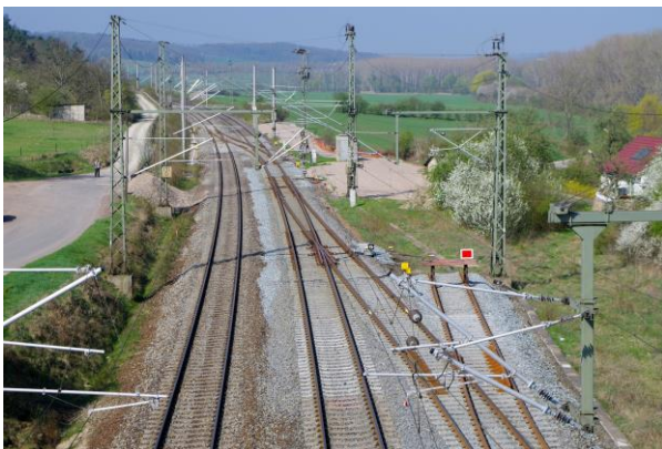
Auf dem Westkopf Bf Seebergen war für die geplante Geschwindigkeit 200 km/h der Bogen aufzuweiten, Weichen werden mit beweglichen Herzstücken ausgerüstet.
