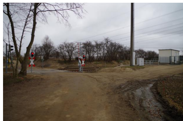
Bahnübergang km 191,3 und ESTW-A im Bf Blankenhof
