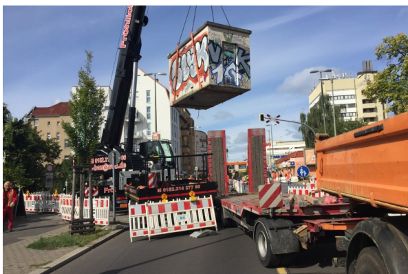
Vollsperrung, Abtransport des alten Schalthauses
