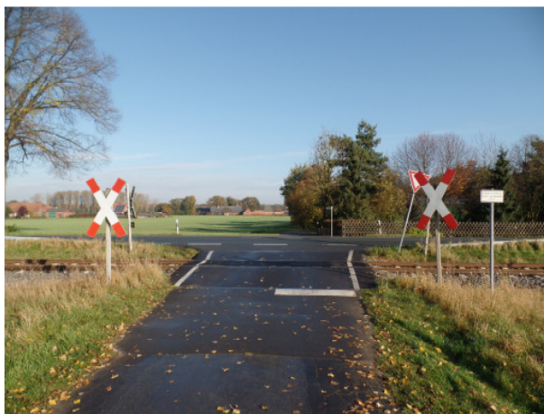
nicht technisch gesicherter Bahnübergang Strecke 2013
