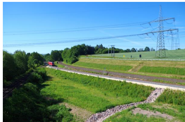
vorn die neu errichtete Verbindung zwischen den Strecken nach Saalfeld (hinten) und Greiz / Weischlitz (links)
