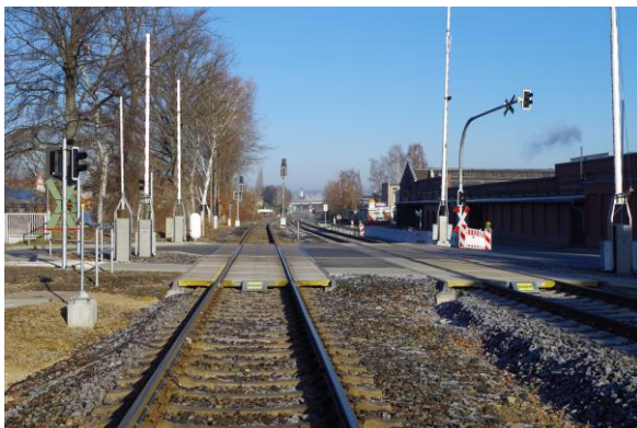
zweigleisig ausgebauter Streckenabschnitt in Gera-Zwötzen mit Änderung des Bahnübergangs Lange Straße
