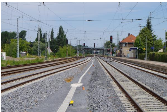
Ausbau der durchgehenden Hauptgleise 1 und 2 der Strecke 6135 sowie der Nebengleise im Bahnhof Elsterwerda
