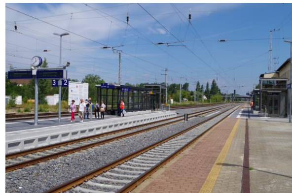
Neubau des Mittelbahnsteiges, der Personenunterführung incl. der Treppenaufgänge und Aufzugsanlagen
