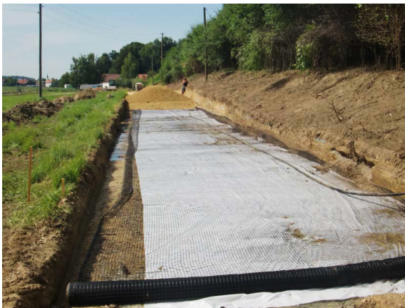
Einbau des Geokunststoffes mit Geogitter zur Untergrundstabilisierung
