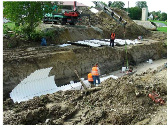
Einbau Durchlassbauwerk am BÜ 4,6
