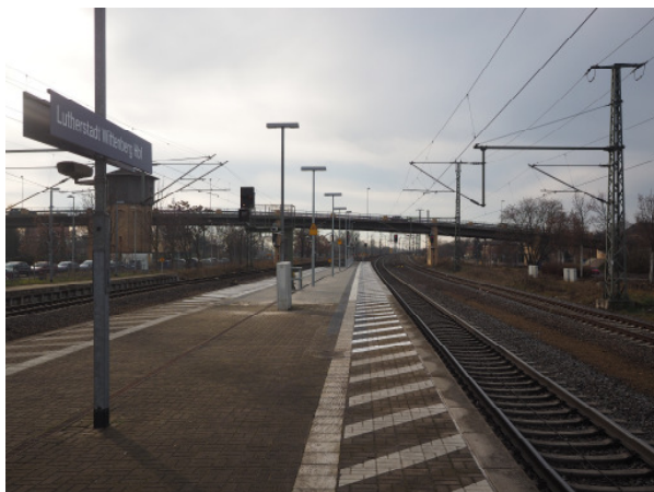
Bf Lutherstadt Wittenberg: Übergang zwischen vorhandenem Bahnsteig und bereits realisierter Bahnsteigverlängerung
