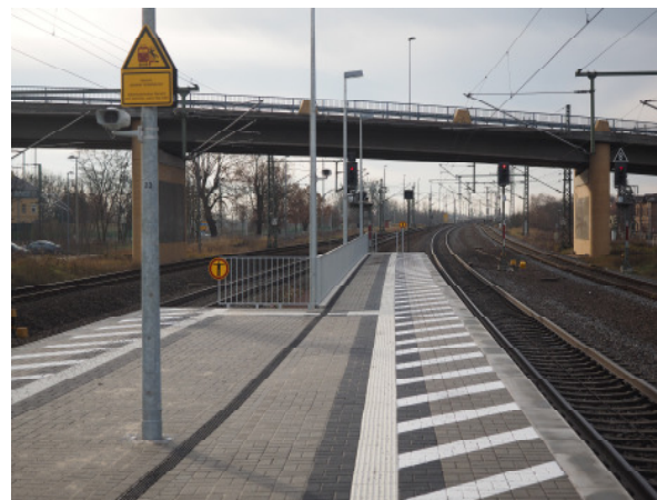
Bf Lutherstadt Wittenberg: aufgrund unterschiedlicher Signalstandorte waren die Bahnsteigkanten an jedem Gleis verschieden zu verlängern
