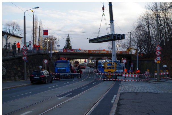
Einbau Hilfsbrücke EÜ Hamburger Straße
