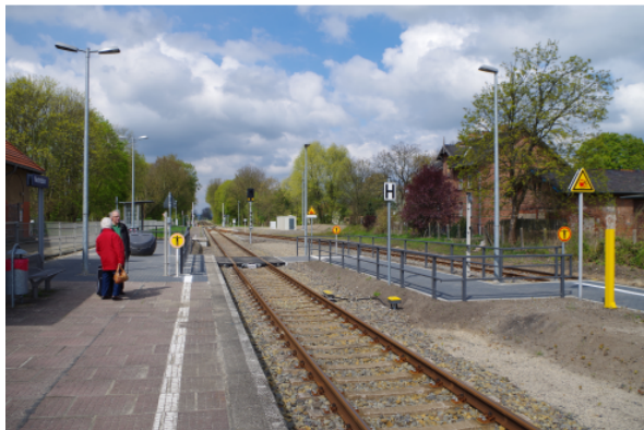
Bf Neutrebbin mit erneuerten Gleisen, einem neu angelegten Reisendenübergang und Bahnübergang km 84,1
