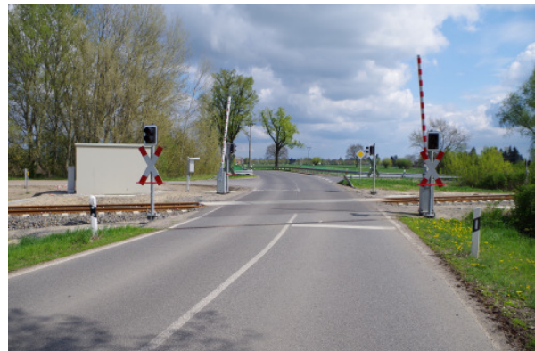
Bahnübergang km 92,8 im Bf Letschin
